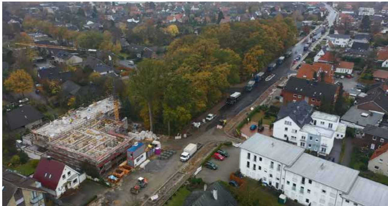
Oyther Straße - Einbau Asphaltdeckschicht 2. Bauabschnitt (Vogelperspektive Blickrichtung Süd-West, November 2020)
