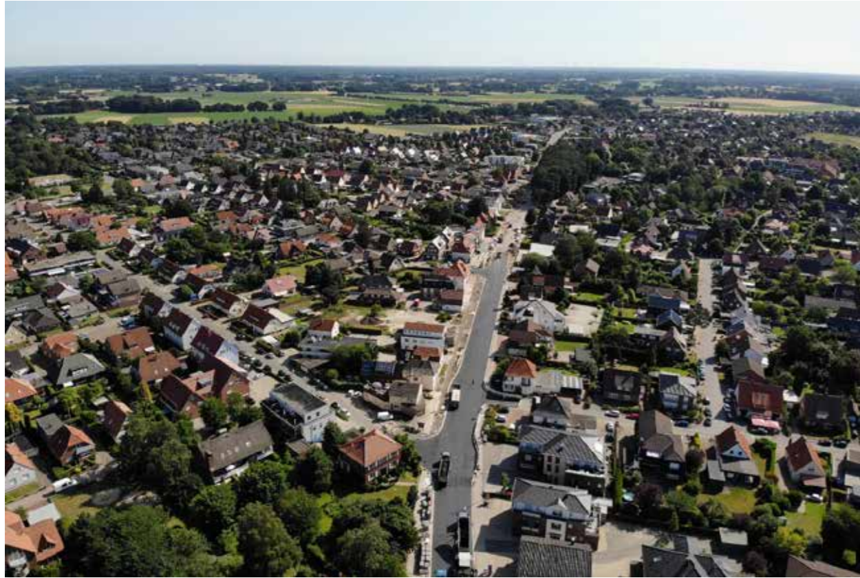
Oyther Straße - Einbau Asphaltdeckschicht 1. Bauabschnitt (Vogelperspektive Blickrichtung Osten, Juli 2020)
