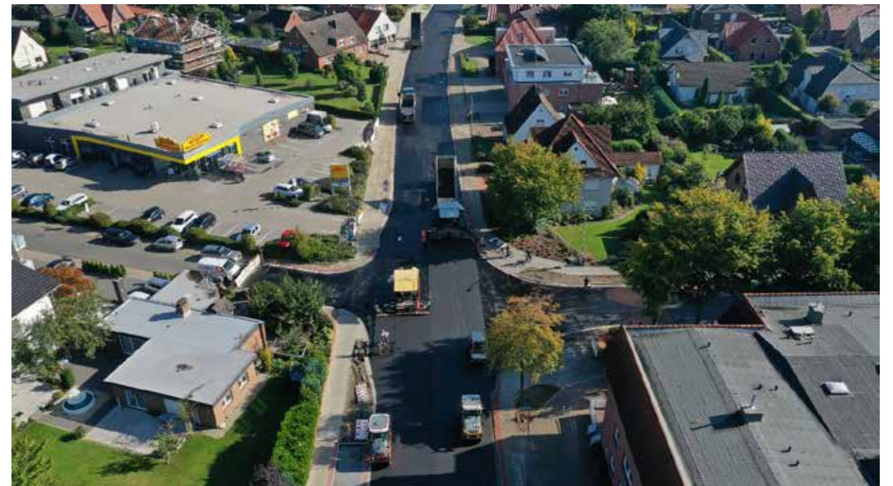
Oyther Straße - Einbau Asphaltdeckschicht 3. Bauabschnitt (Vogelperspektive Blickrichtung Nord-Ost, September 2021)
