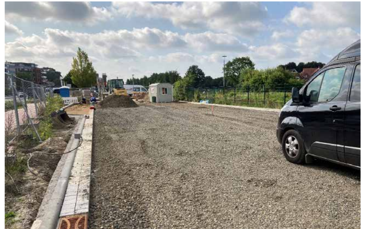
Straßenbauarbeiten – Bord- und Rinnenanlage sowie Schottertragschicht (September 2021)
