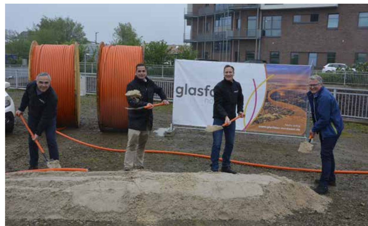
(v.l.n.r) Carsten Höfinghoff (Regionalmanager bei Glasfaser Nordwest), Kristian Kater, Sascha Zink (Leiter Kommunales und Politik bei Glasfaser Nordwest), Gerhard Niemann (Kommunalbetreuer bei EWE Netz) Foto: Fischer
