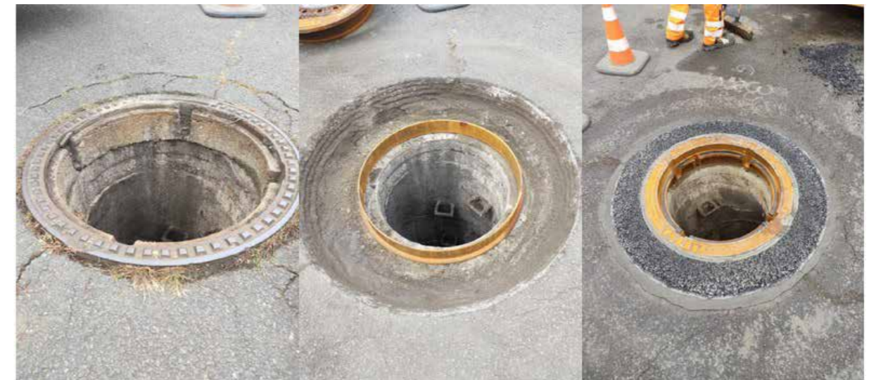
Bild: Schachdeckel vor, während und nach der Sanierung
