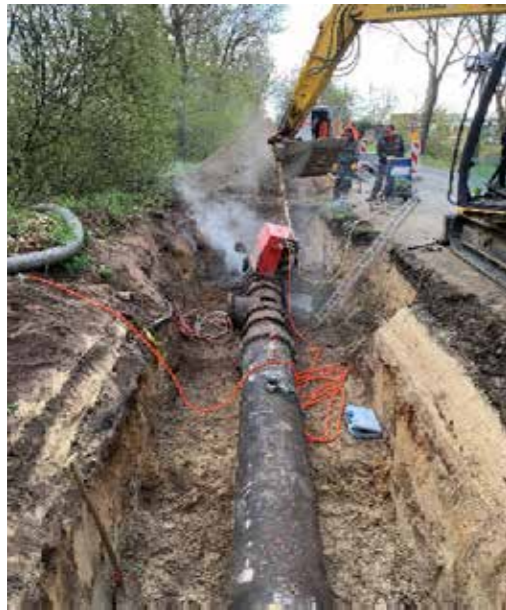
Bild: Ausschneiden mittels Umlaufbandsäge
