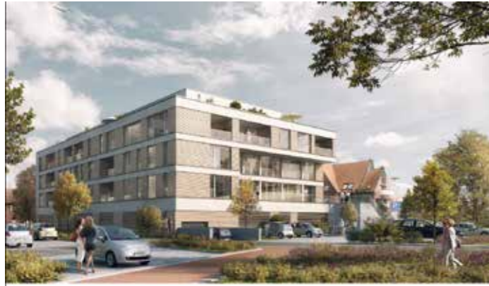
Vorhaben – Ansicht von der Gildestraße – unmaßstäblich
