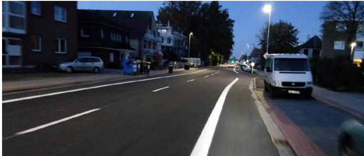
Oyther Straße – Fahrbahnintegrierter Radweg im 3. Baubchnitt (November 2021)
