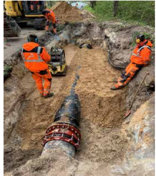
Bild: und Verfüllen des Austauschstück
