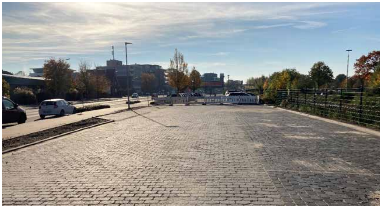
Straßenbauarbeiten – Pflaster Fahrbahn und Stellplätze (Oktober 2021)
