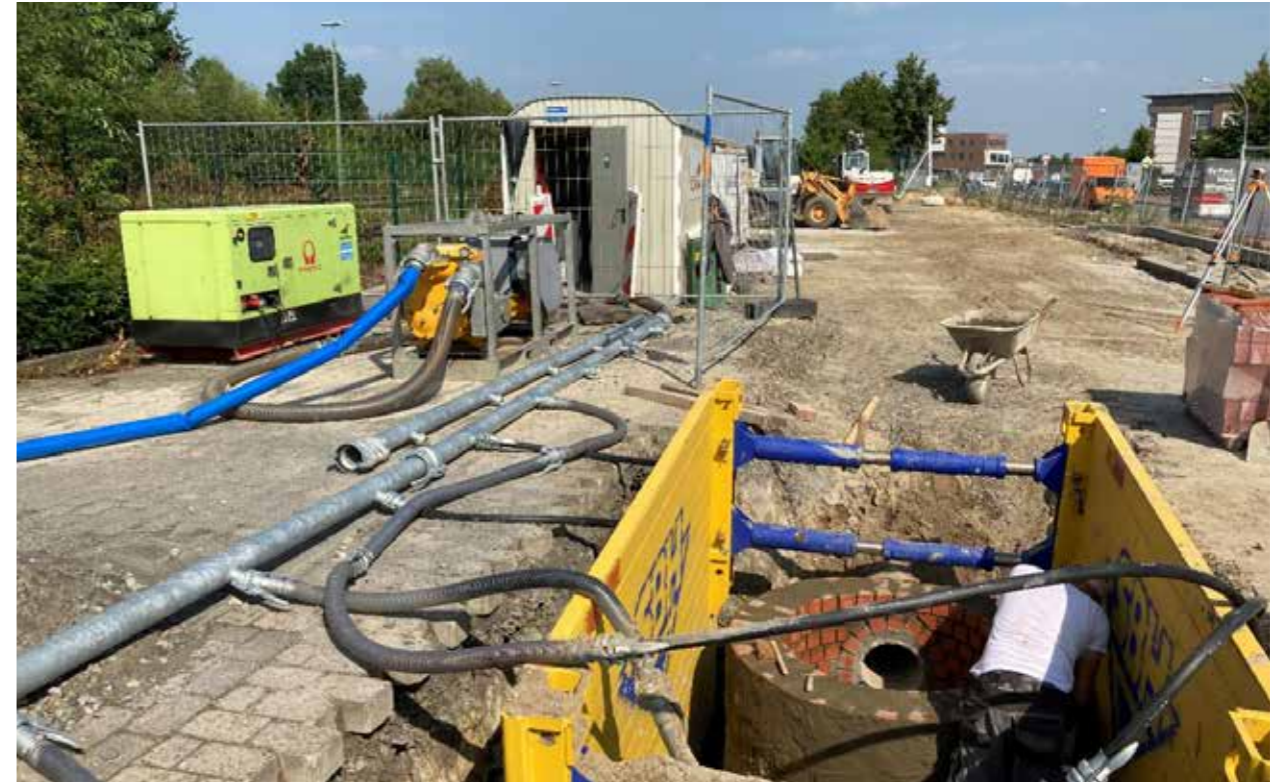
Kanalbauarbeiten – Schachtbauwerk mit Wasserhaltung (August 2021)
