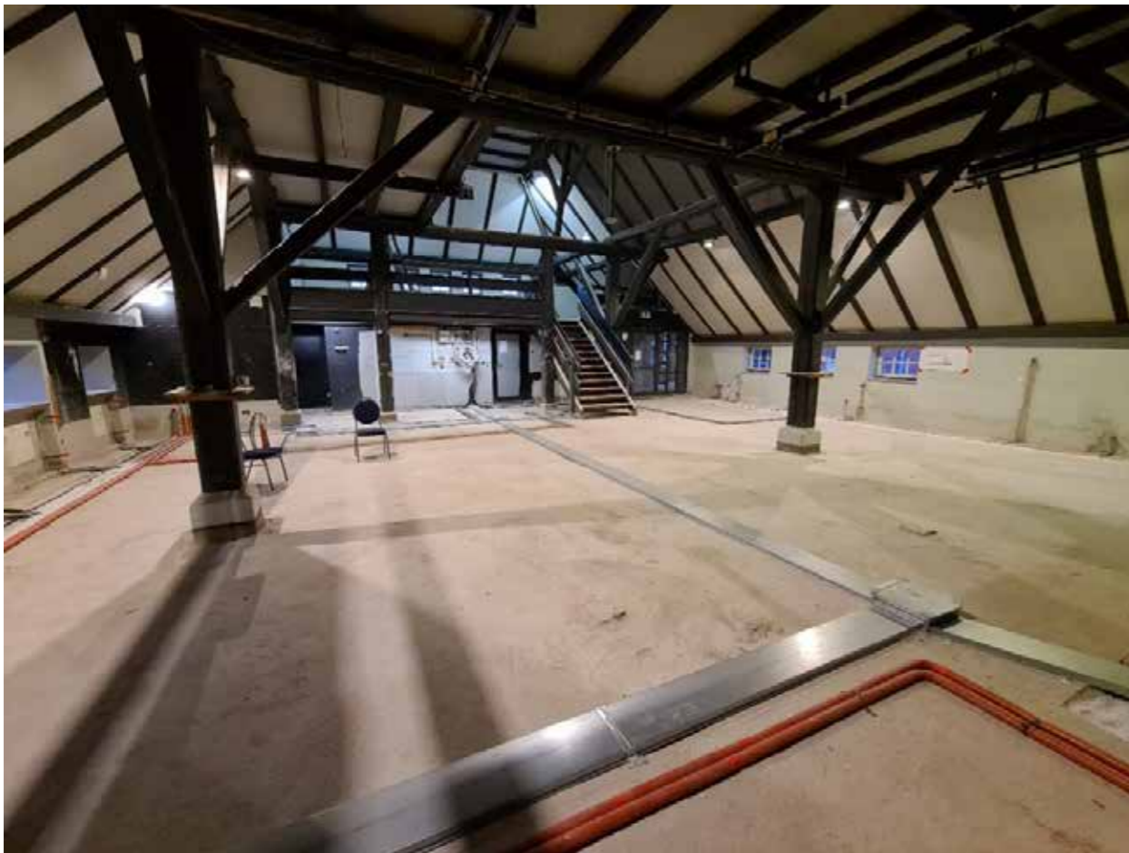
Bauphase: Installation von Versorgungskanälen unterhalb des Estrichs
