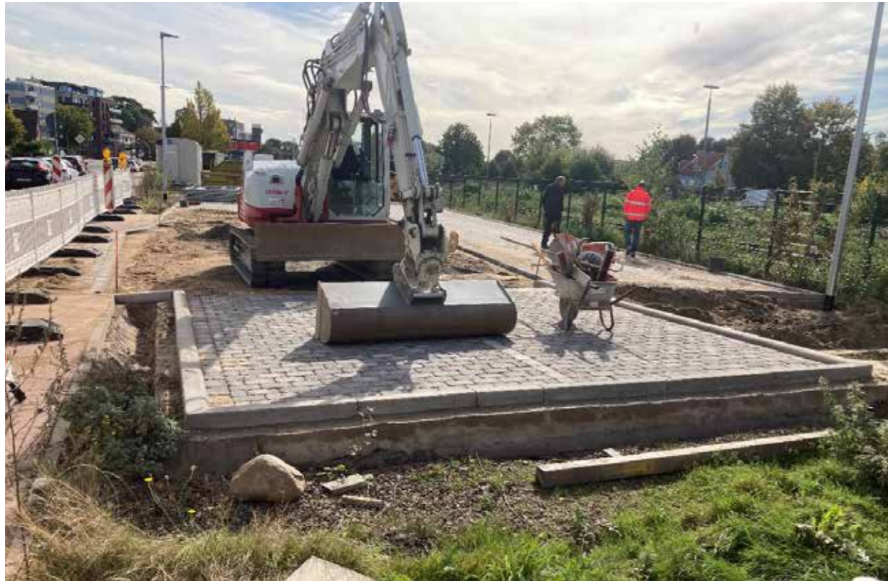
Straßenbauarbeiten – Pflaster und Rahmen Stellplätze (Oktober 2021)
