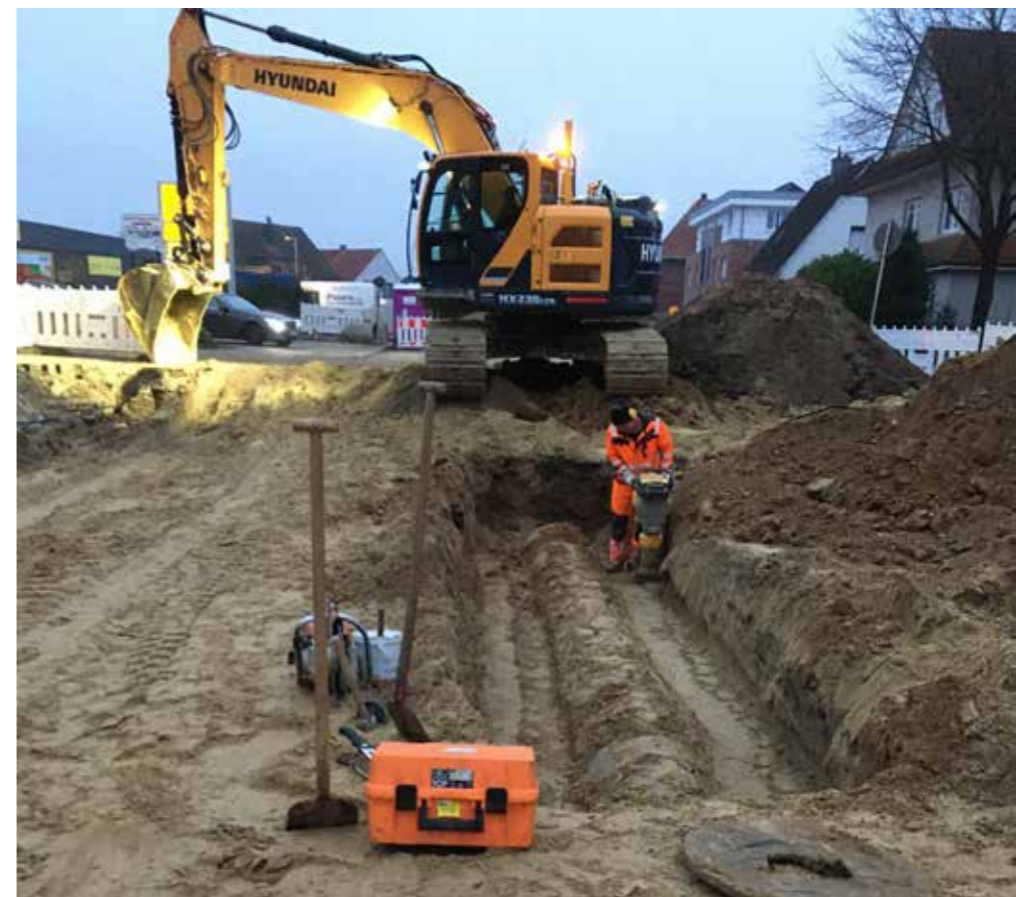
Oyther Straße - Verlegearbeiten Regenwasserkanal im 3. Baubchnitt (Dezember 2020)
