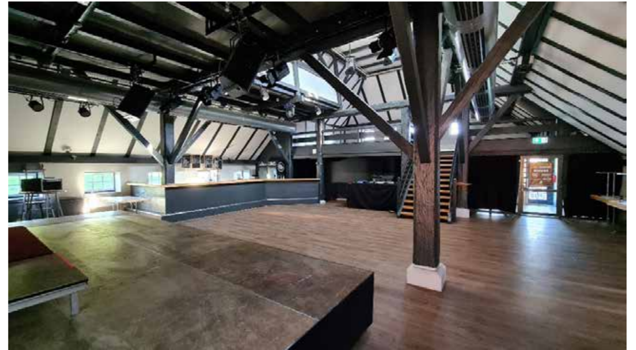
Fertigstellung 2021: Die Sanierung ist abgeschlossen – kleine Restarbeiten müssen noch erledigt werden.
