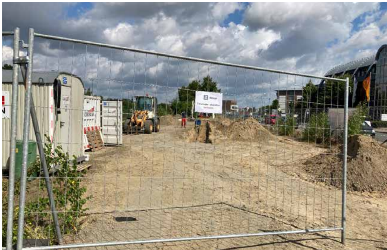
Kanalbauarbeiten – Trasse Regenwasserkanal (Juli 2021)
