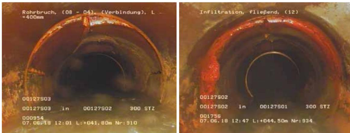
**Bild: Schadensbilder Rohrbruch und eindringendes Grundwasser im Schmutzwasserkanal der Dresdener Straße**
