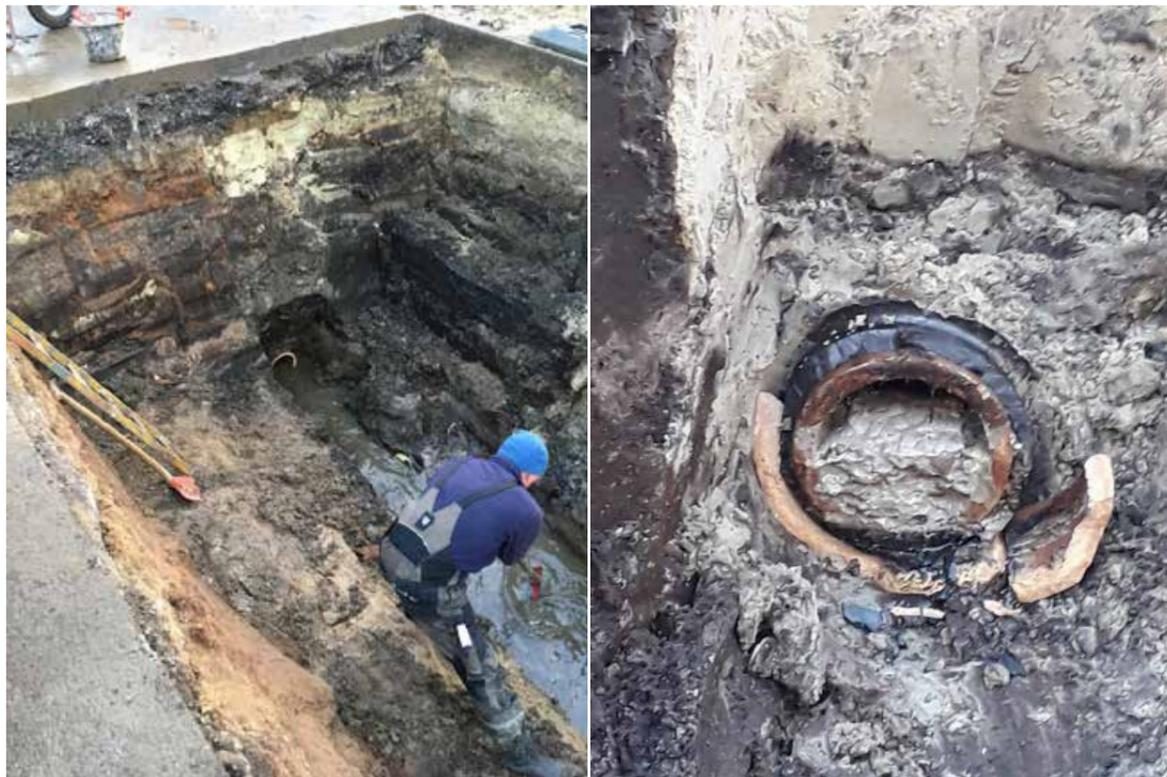
**Bild: Verstopfung des Schmutzwasserkanals und des Hausanschlusses mit Beton**
