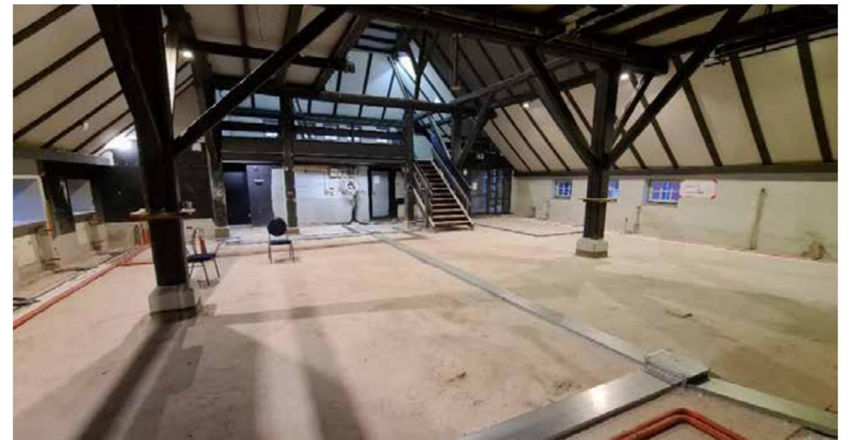
Bauphase: Installation von Versorgungskanälen unterhalb des Estrichs
