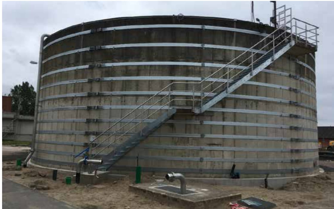
Bild: Mit Spannbändern und Betonschürze stabilisierter Schlammspeicher mit erforderlichen Rohranbindungen.
