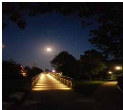
Rampe Widerlager West Zitadellenpark
