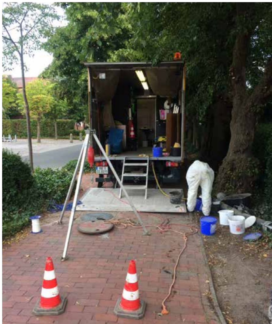
Sanierungsfahrzeug auf dem Gehweg zur Zitadelle
