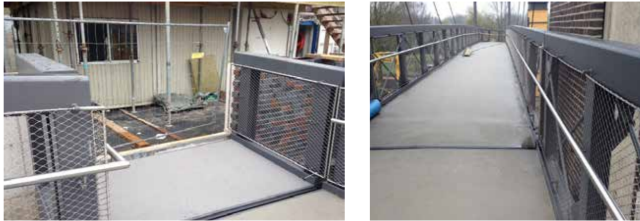
Bild links: Anschlussbrücke zu den Stadthäusern (Übergang) eingehoben und montiert. (März 2018)
