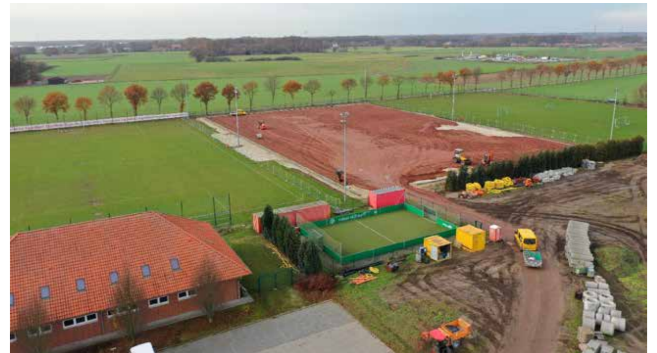
Neubau eines Kunstrasenplatzes am Oyther Berg Stand Ende 2018
