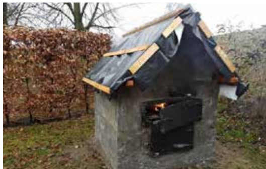
Rohbau des Backofens, Dach und Außenputz fehlen noch
