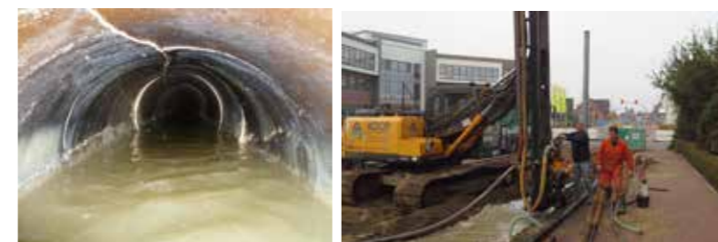
Bild links: Scherbenbildung im Kanal aufgrund von Materialermüdung
