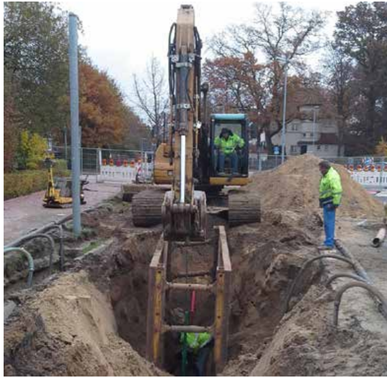
Bild: Erneuerung des Kanals in offener Bauweise
