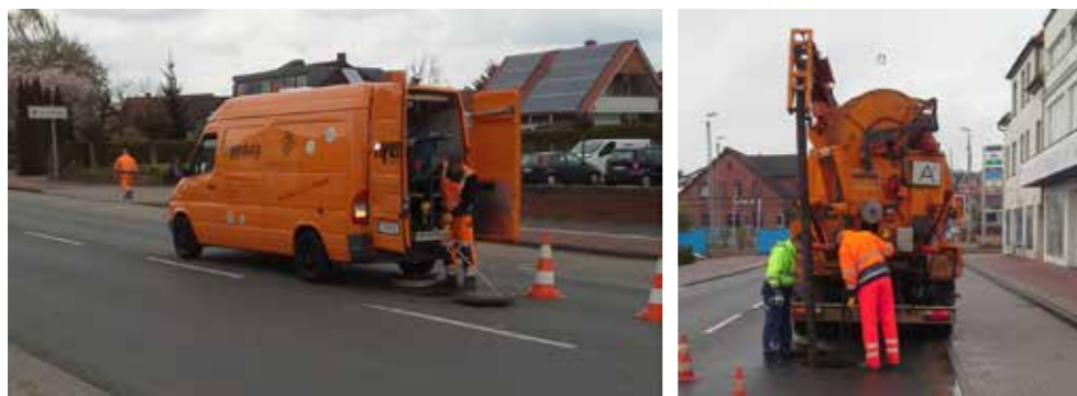
Bild: Kamerawagen und Spülwagen im Einsatz
